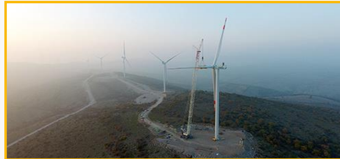
VESTAS - Balıkesir Rüzgar Türbin Montajı
