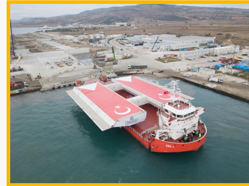
1915 Çanakkale Köprüsü Tabliyelerinin Taşınması Projesi
